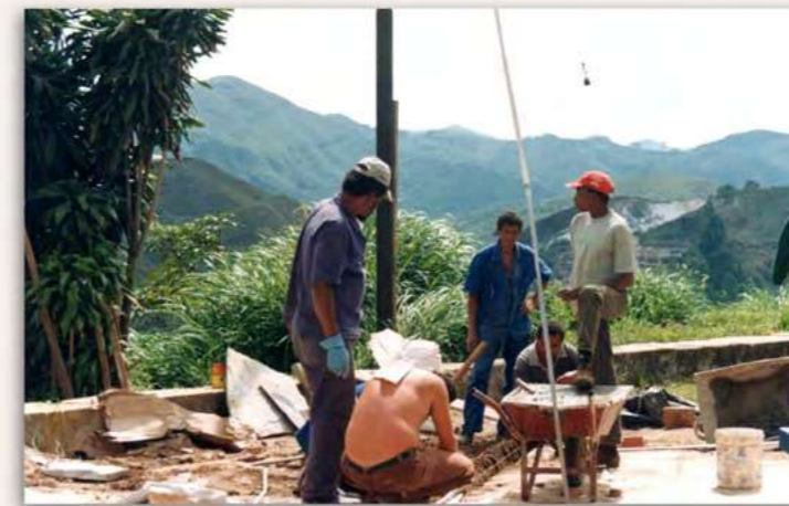
Obras de restauração para implantação do Museu do Oratório
